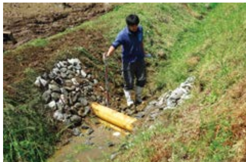
生物多様性水路の設置
