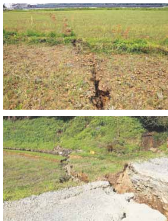
熊本地震で地割れが生じた益城町の水田
