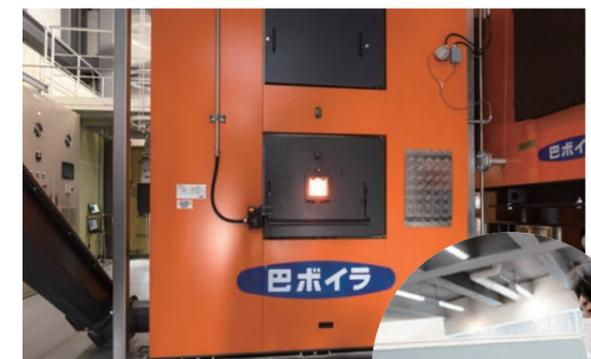
上: バイオマスボイラーでは、CO<sub>2</sub>を吸収して育った木を燃料としているので大気中の炭素量は増加しない 右: 電力やバイオマスボイラーの運用をマネジメントシステムによって効率的に管理
