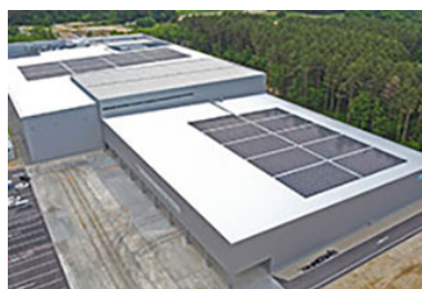
サントリー天然水 北アルプス信濃の森工場
