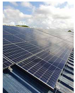
樽熟庫屋根に新設置された ソーラーパネル
