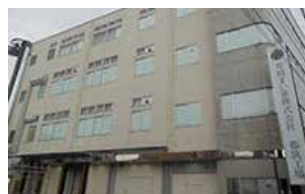
都筑工場全景
