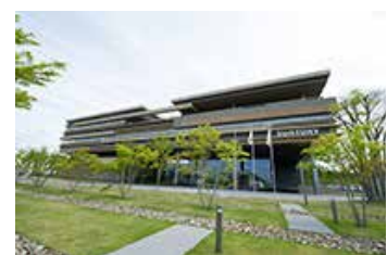
サントリー ワールド リサーチセンター
