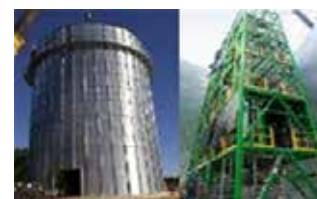
実証プラント
