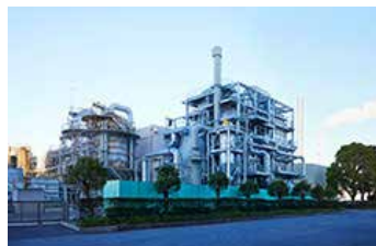
バイオマスボイラー （サントリー知多蒸溜所）
