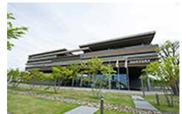
サントリー ワールドリサーチセンター
