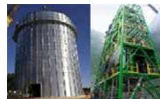
実証プラント
