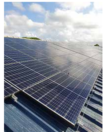
樽熟庫屋根に新設置された ソーラーパネル
