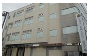
都筑工場全景
