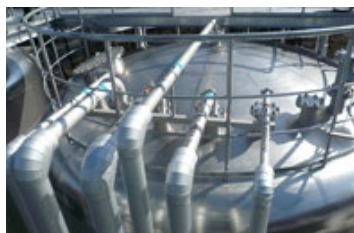
清浄レベルごとに回収した 水を200トンのタンクに貯蔵し再利用
