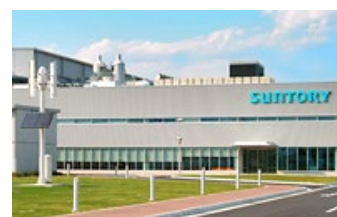
雨水を植栽の散水に活用している サントリープロダクツ (株) 神奈川県綾瀬工場
