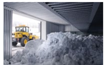
サントリープロダクツ（株） 天然水奥大山ブナの森工場の雪室
