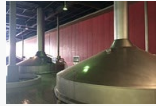
サントリービール（株） 利根川ビール工場の新設釜
