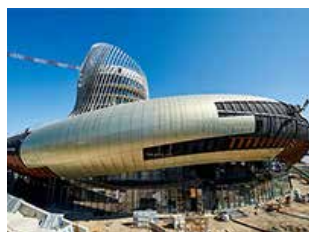
建設中の ラ・シテ・ドゥ・ヴァン
