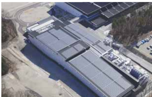
▲サントリープロダクツ(株)天然水南アルプス白州工場太陽光発電パネル
