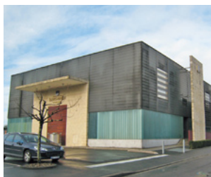
最新式びん詰めライン棟
