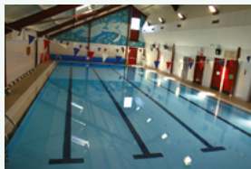
廃熱を利用した温水プール
