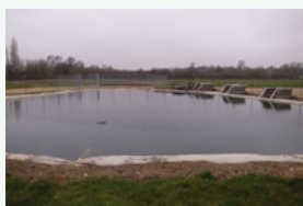
蒸溜冷却水の貯水槽
