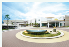
環境に配慮したタイの新工場
