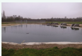
蒸溜冷却水の貯水槽
