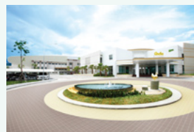
環境に配慮したタイの新工場
