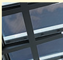
光透過型の太陽光発電パネル
